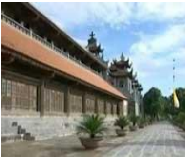
Nhà Thờ Lớn nhìn từ phía sau
